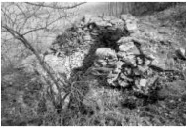
Cette cadole est insérée dans un mur de soutènement d'un mètre d'épaisseur renforcé à sa base par un autre mur d'un mètre. Elle est séparée d'un chirat par un escalier très endommagé.
