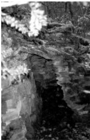
Le chemin des Selles passe au-dessus d'un mur de soutènement de 2,5m de haut ; il coupe un chirat appareillé des deux côtés de 2,5m de large. Dans celui-ci est incluse cette cadole au plan de base trapézoïdal et dont les parois prennent, à partir de 0,2m du sol, des formes complexes pour faire des sièges, des niches.
