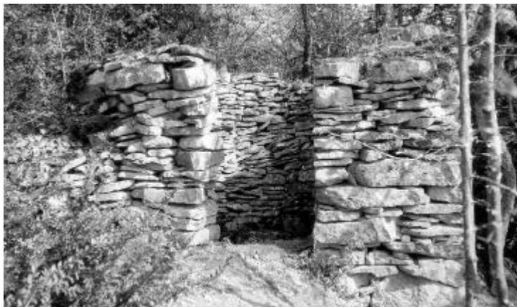
Cadole bâtie en aval d'un chirat. Il n'en subsiste que le mur circulaire, à double parement hors du chirat où elle est incluse. Le haut de ce mur est en parti couronné de grosses pierres qui participaient au chaînage d'assise de la voûte écroulée.
